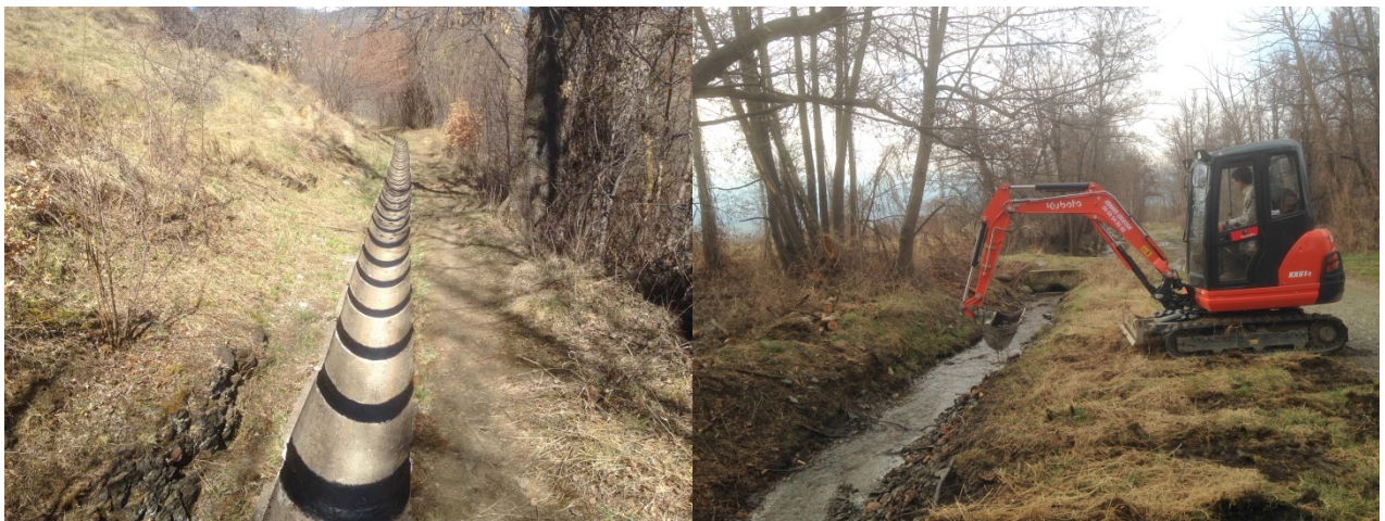
Colmatage au goudron des joints curage de l'ensablement Canal Plandails Canal Soulane
