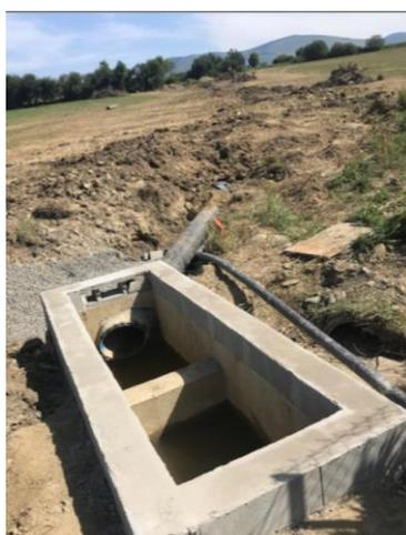
Ces travaux ont été réalisés aux frais de l'ASA, en raison de l'amélioration substantielle apportée par les promoteurs à l'écoulement de l'eau entre le chemin de Llivia et le CD30 (Route de Caldégas) sur une longueur de 170 mètres.
